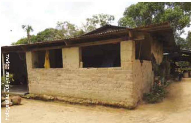
Foto 33. Vista de vivienda tradicional del llanero construida con adobe, Predio Villa Mar, vereda Ele Perocero.
